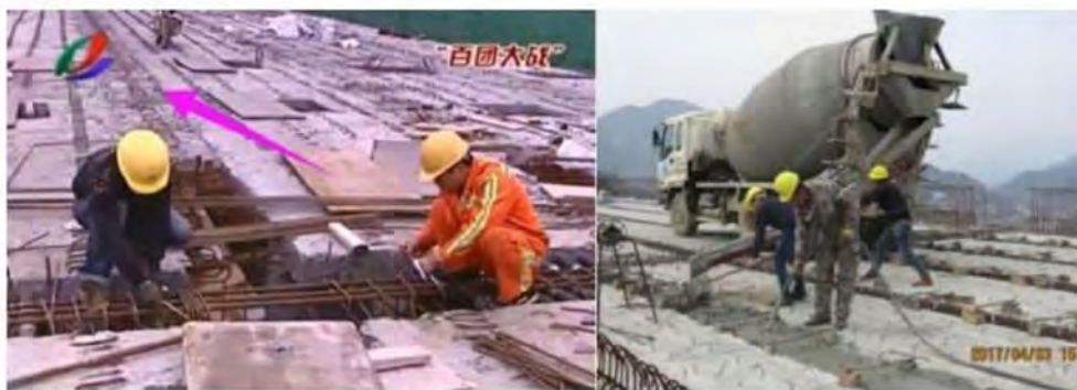
先湿接缝混凝土后湿接头混凝土
